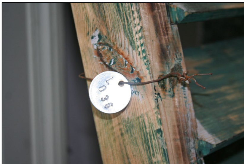
Zonneblinden blijvend herkenbaar door een metalen plaatje met codering, zodat na herstel bij het terugplaatsen geen misverstand mogelijk is.
