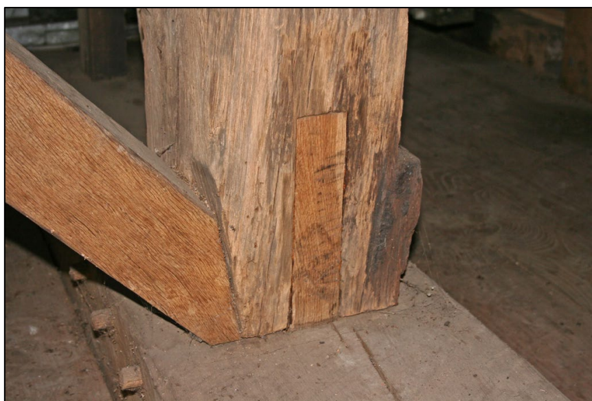
Een stijl gerepareerd door deze te voorzien van een nieuwe losse pen om de getoogde verbinding te herstellen.
